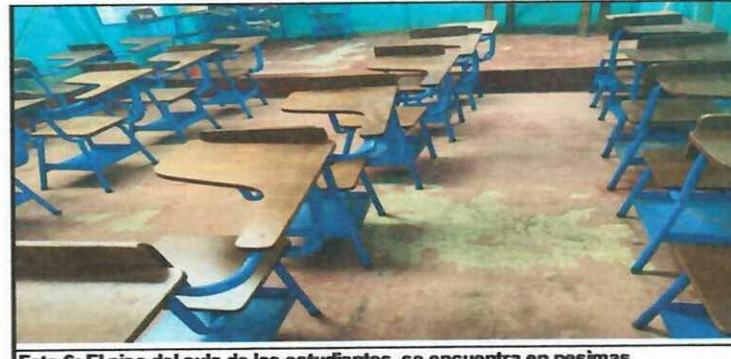
Foto 6: El piso del aula de los estudiantes, se encuentra en pesimas condiciones, y con el pasar de los dias se sigue picando.
